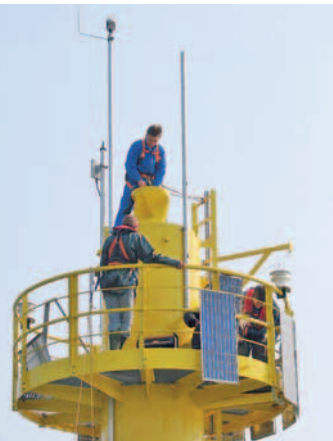
Der Messpfahl Rochelsteert liefert der WSD wichtige Wasserstandsmeldungen (links). Die wissenschaftlichen Mitarbeiter des FTZ-Westküste der CAU-Kiel bei der Installation der Sensoren und Datentransfersysteme (rechts).
