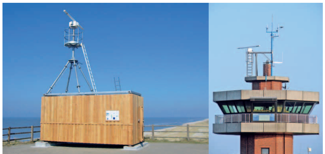
Küstenüberwachungsradaranlagen von Raytheon Anschutz auf der Messplattform Bunker Hill/Rantumer Düne auf Sylt (links) und auf dem Sperrwerk Büsum (rechts)
